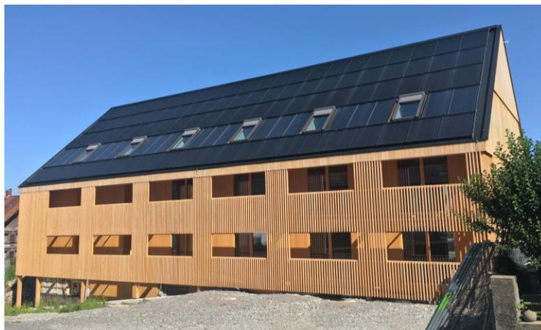
Abbildung 1: Energiedach Photovoltaik und Solarthermie mit Integration von Dachfenstern
