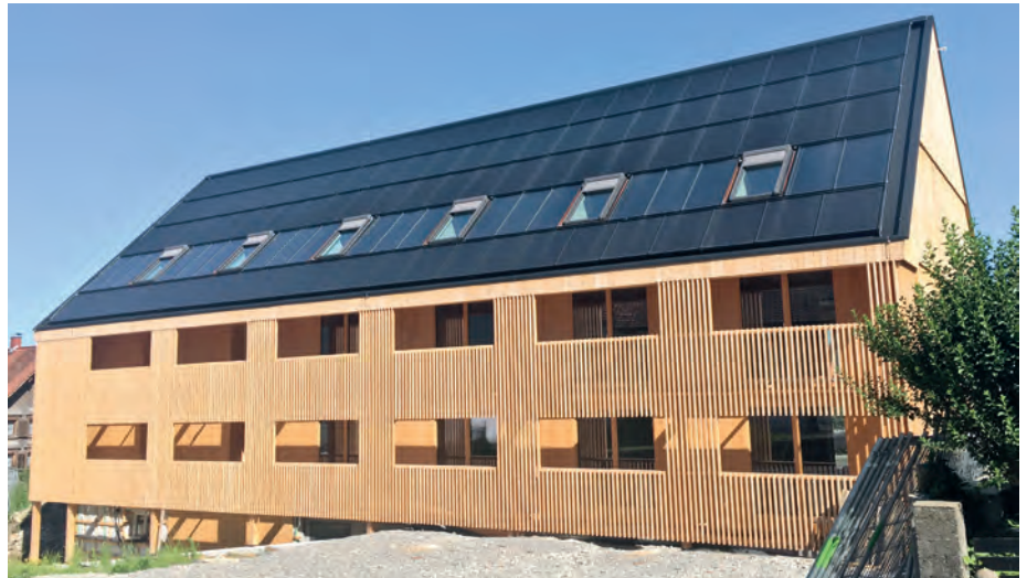
Massgeschneidertes Energiedach mit Photovoltaik, Solarthermie und Dachfenstern.
