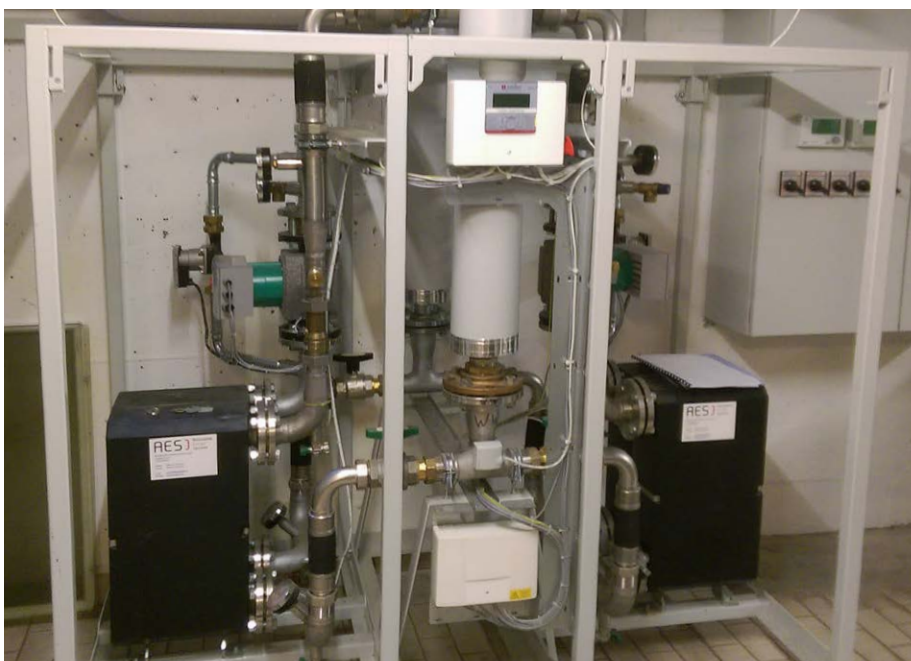
Frischwasserstation FRIWASTA-PLUS 600 l/min (Doppelstation) im Hotel Welcome Inn, Kloten.
